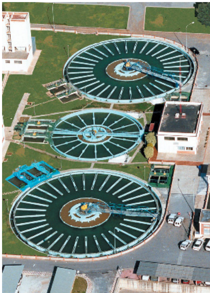
Estación depuradora de El Atabal (Málaga capital)
