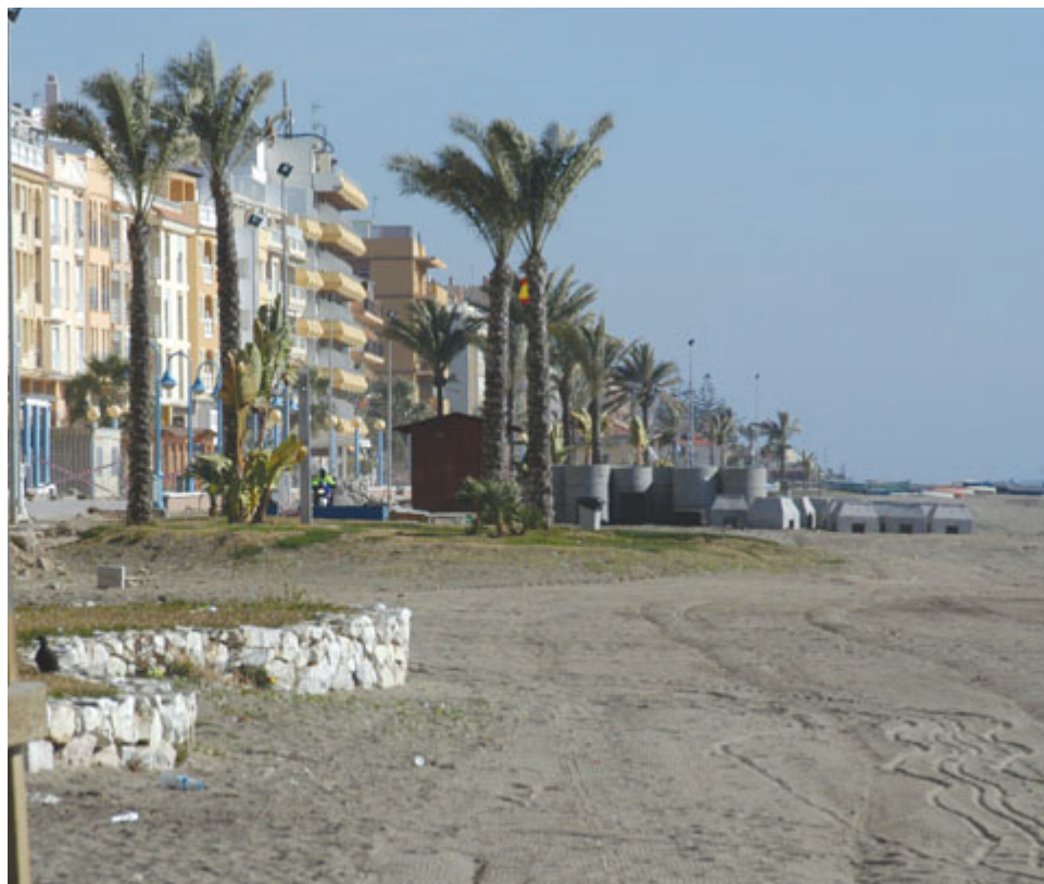
Paseo marítimo de Rincón de la Victoria. Obras de infraestructura posteriores a las inundaciones
