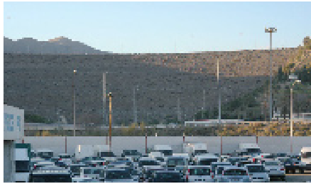
Muro de la presa del Limonero
