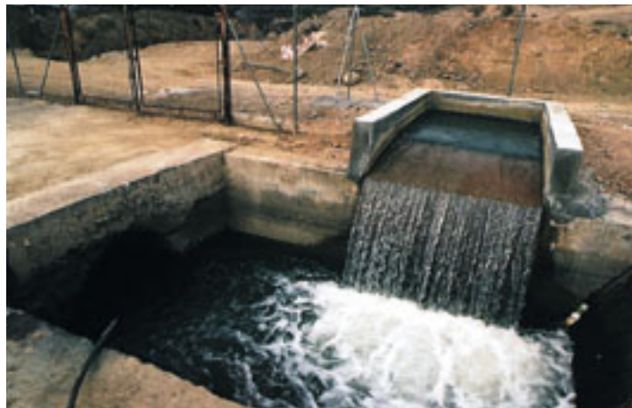
Canal exterior de desagüe
