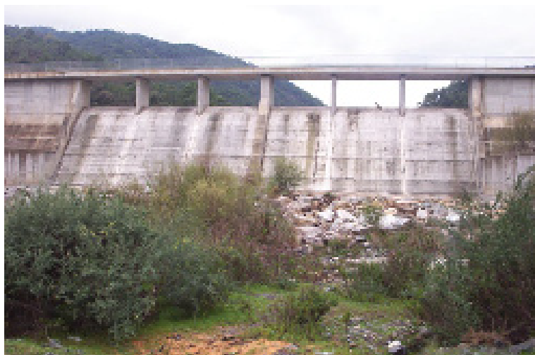
Presa sobre el cauce del río Guadaiza
